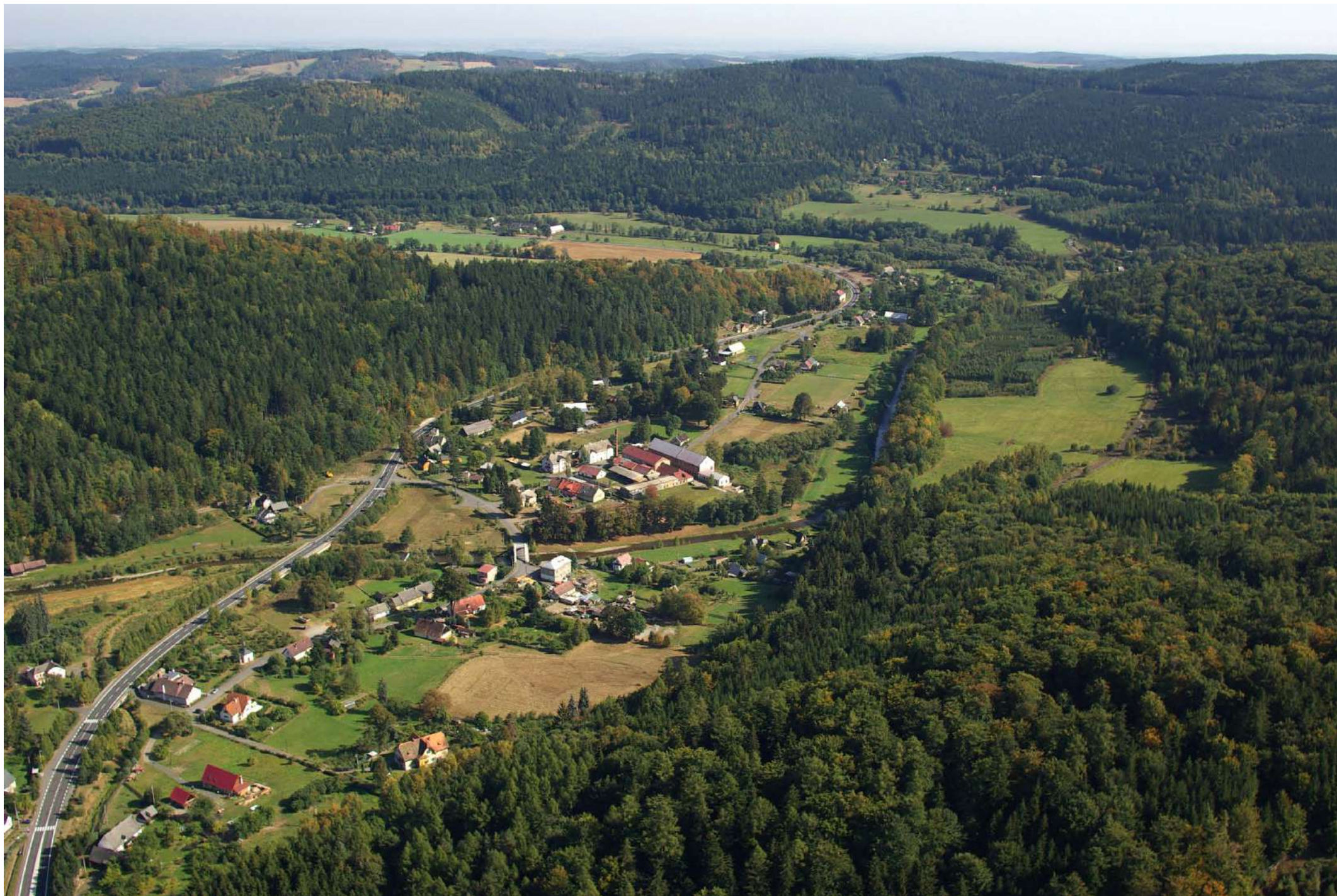
Obec Nové Heřminovy, letecký pohled po vodě - současný stav
