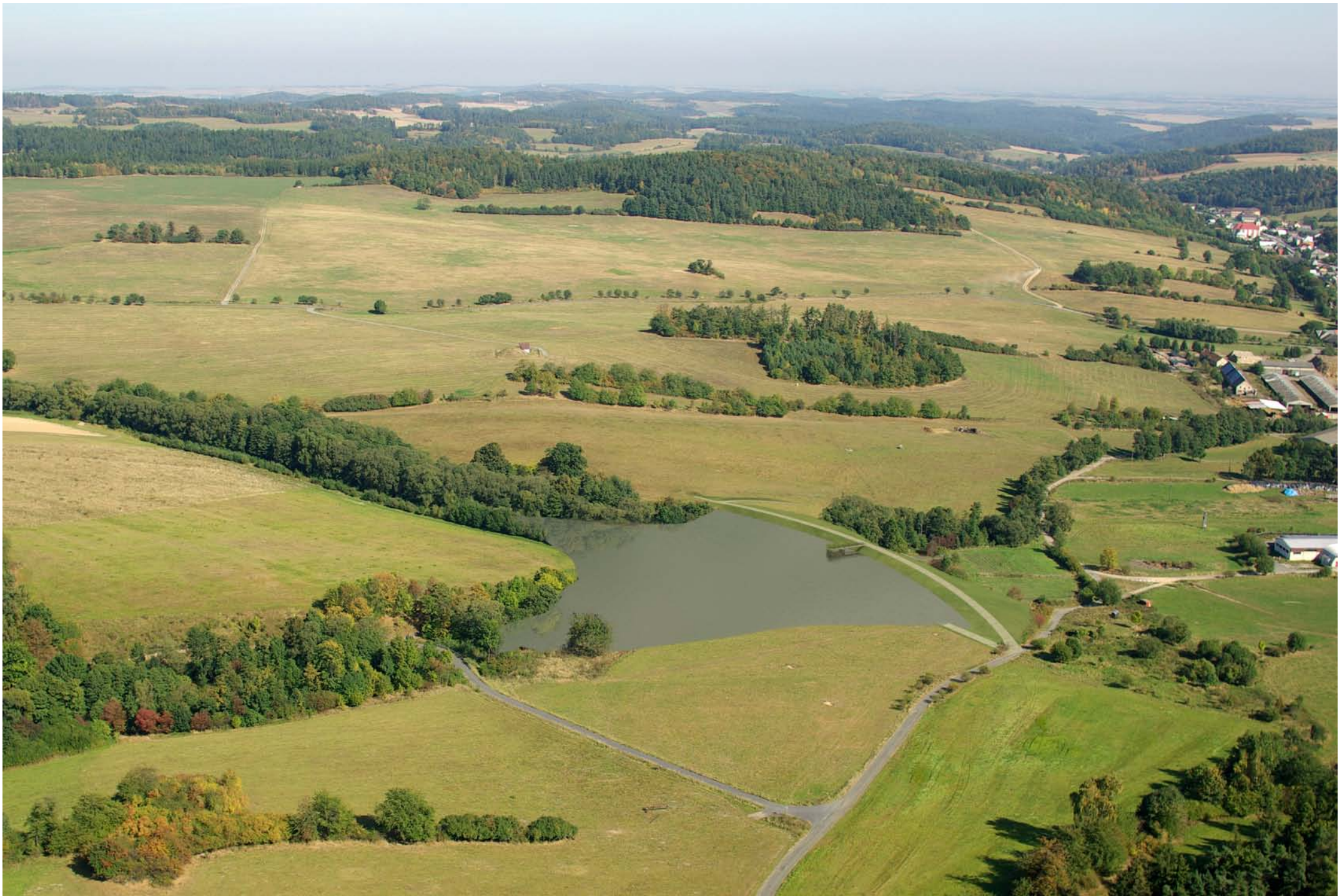
Nádrž Lichnov III, celkový letecký pohled- po realizaci nádrže
