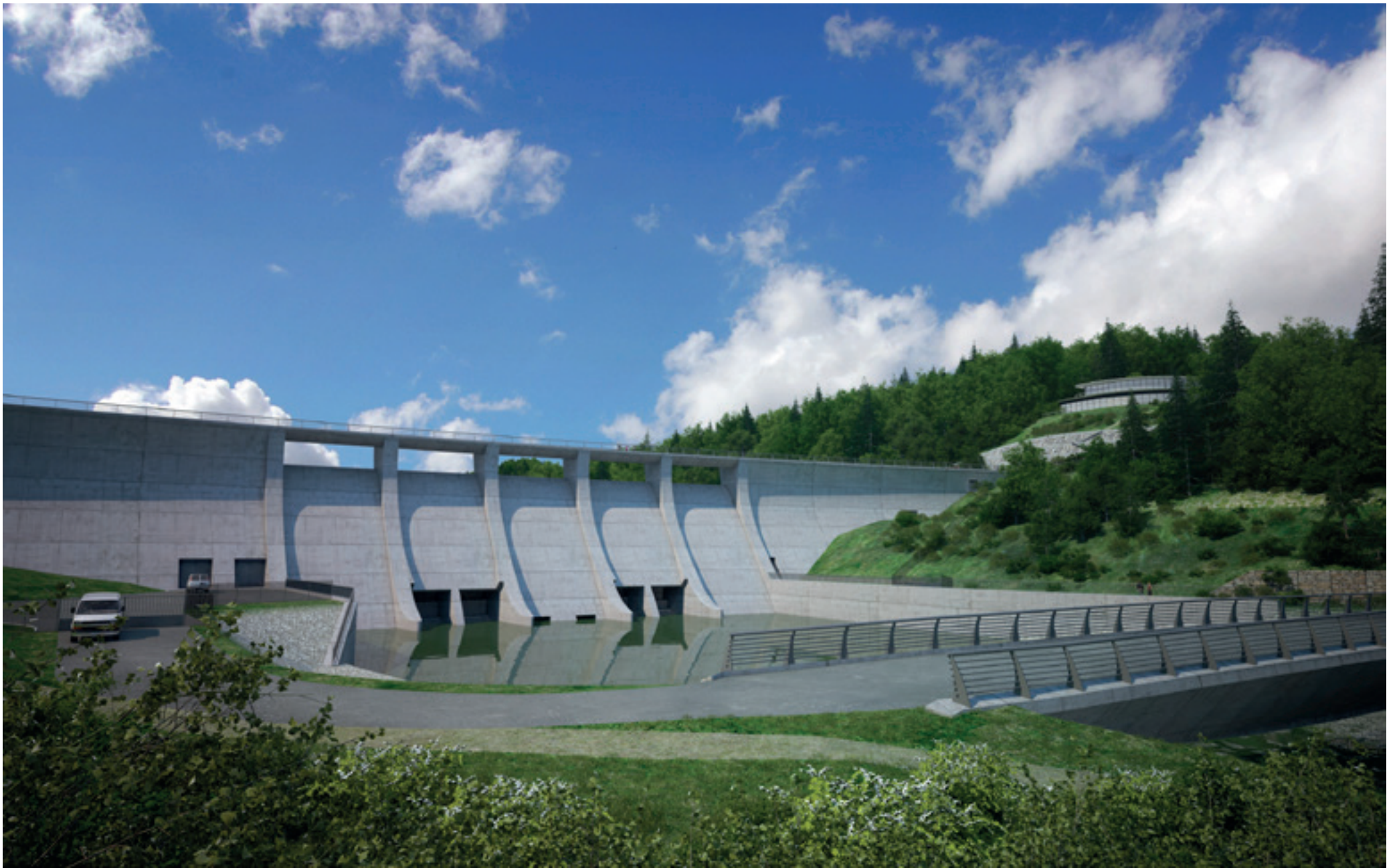
Vodní dílo Nové Heřminovy, pohled na vzdušný líc hráze a vývar
