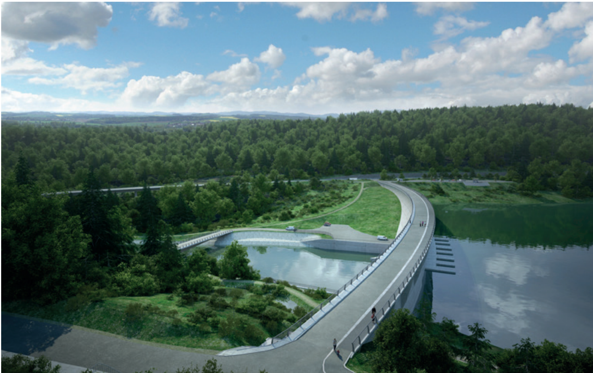
Vodní dílo Nové Heřminovy, pohled na hráz a podhrází
