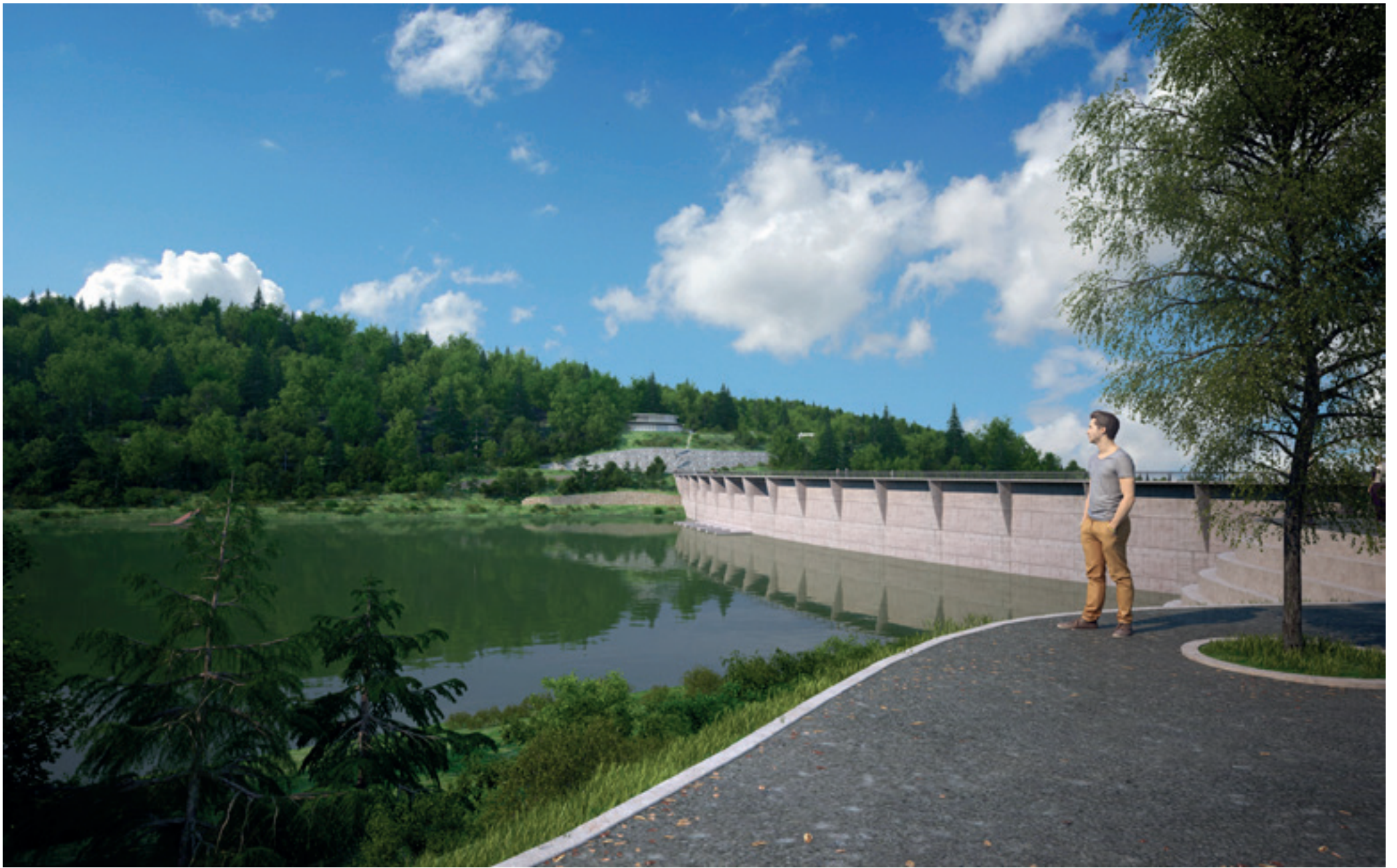
Vodní dílo Nové Heřminovy, pohled na hrázový profil a provozní středisko
