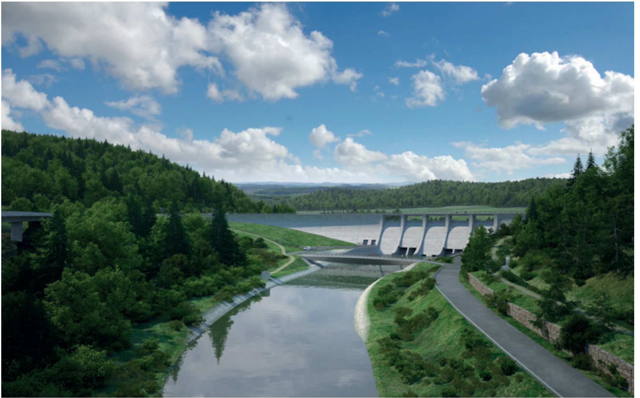
Vodní dílo Nové Heřminovy, pohled na hráz, podhrází, obtokové koryto
