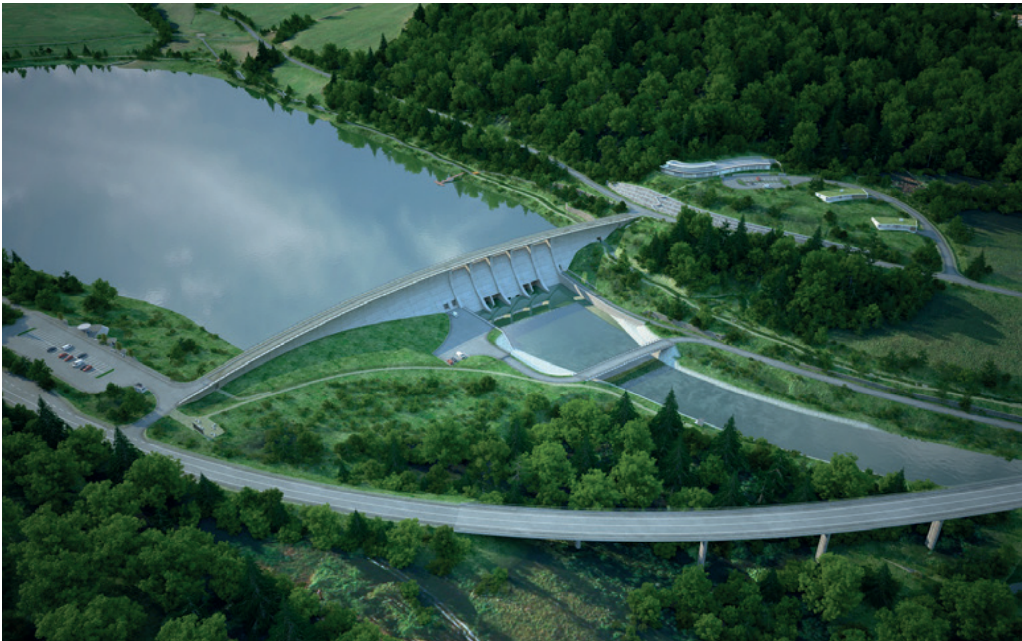
Vodní dílo Nové Heřminovy, letecký pohled na hráz a podhrází, provozní středisko, v popředí estakáda silnice I/45
