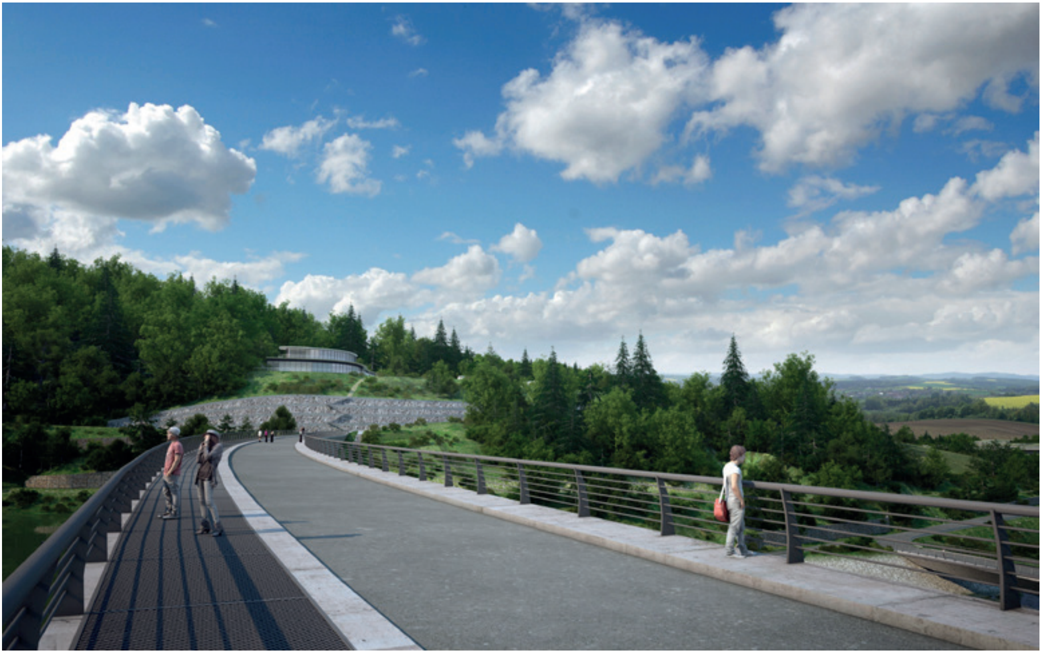
Vodní dílo Nové Heřminovy, pohled na hráz a provozní středisko
