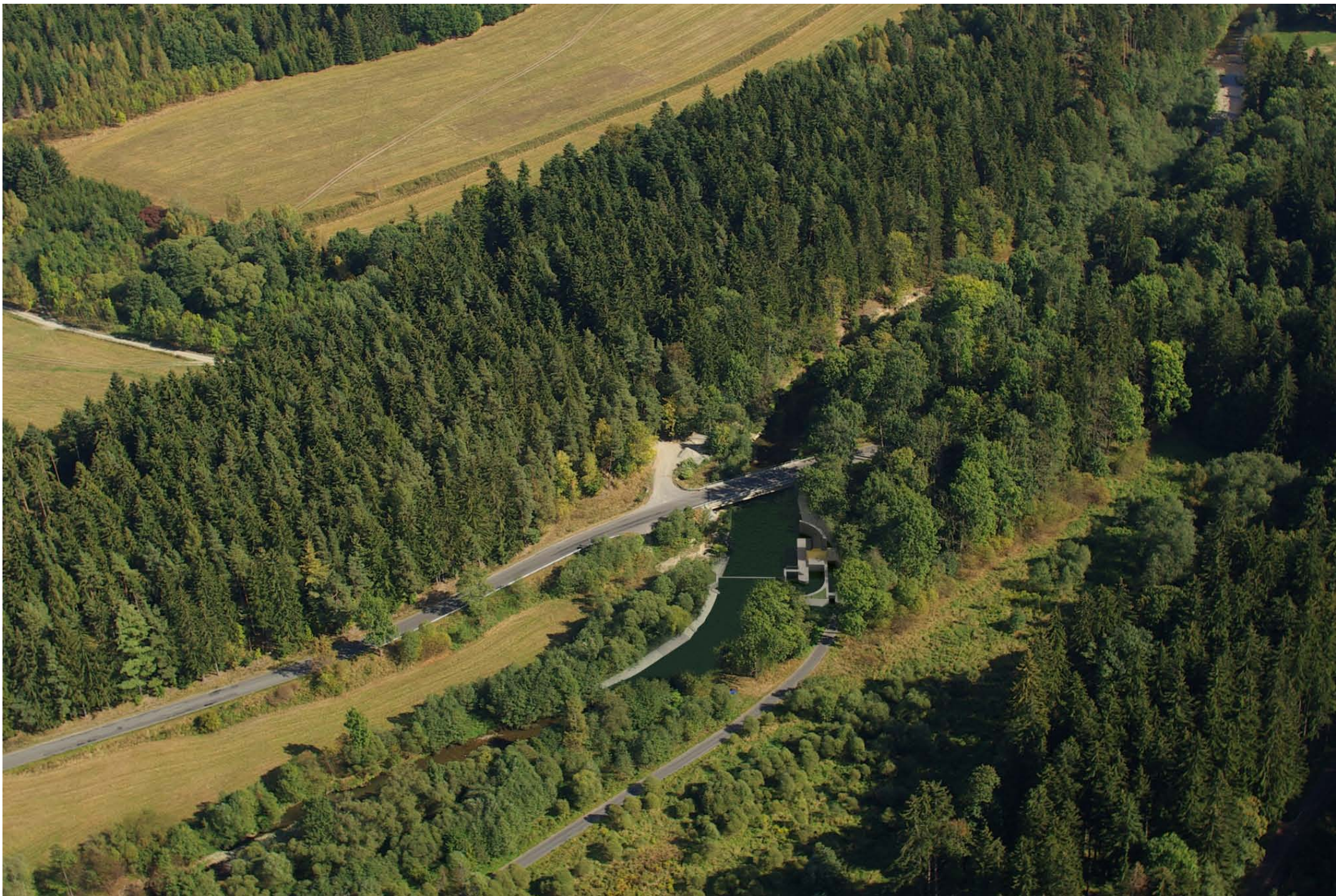
Jez Kunov v km 92,990 dle TPE, letecký pohled po toku – po realizaci MVE a rekonstrukce jezu
