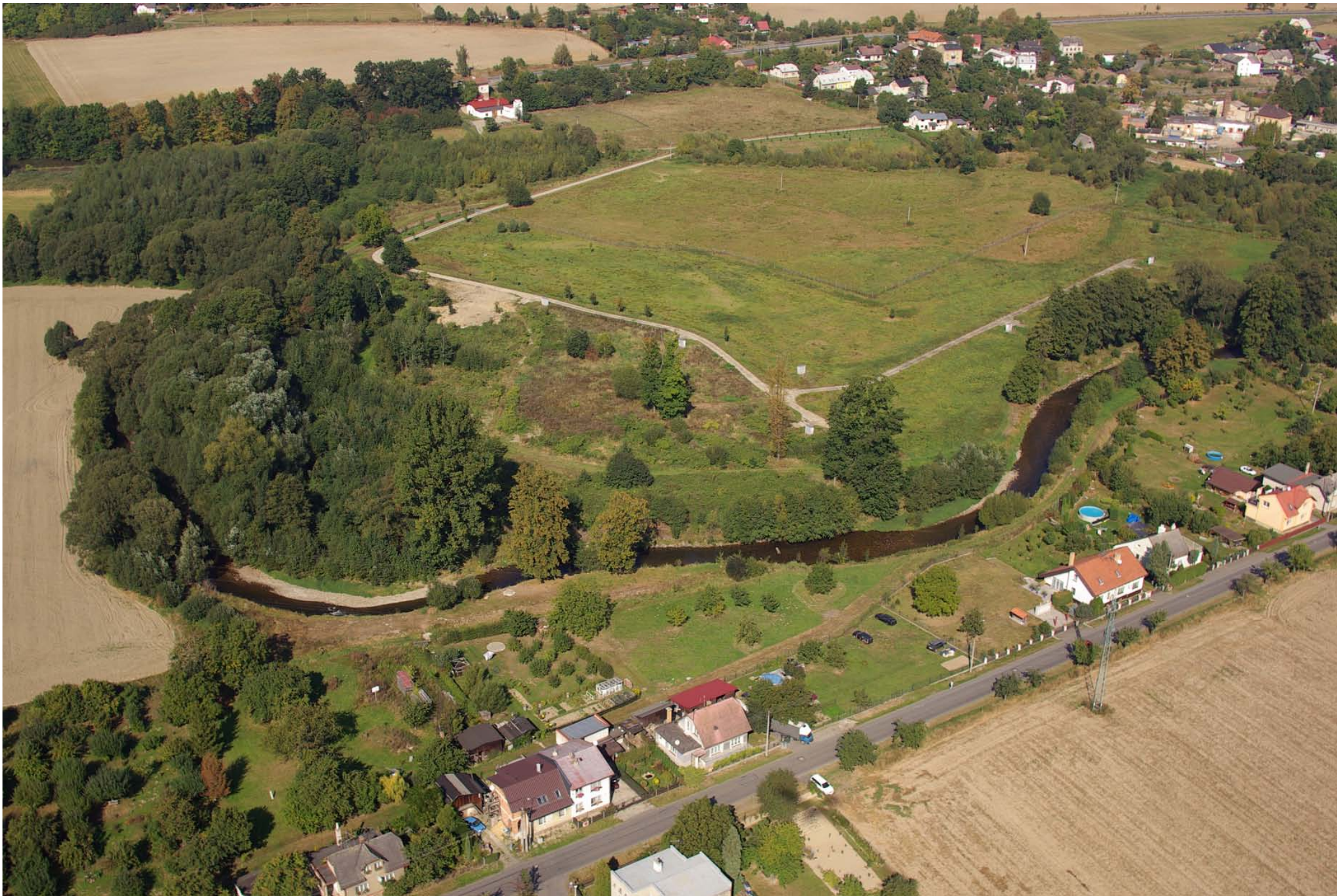
Město Krnov, část Kostelec, letecký pohled na oblast jímacího zařízení KVak - současný stav
