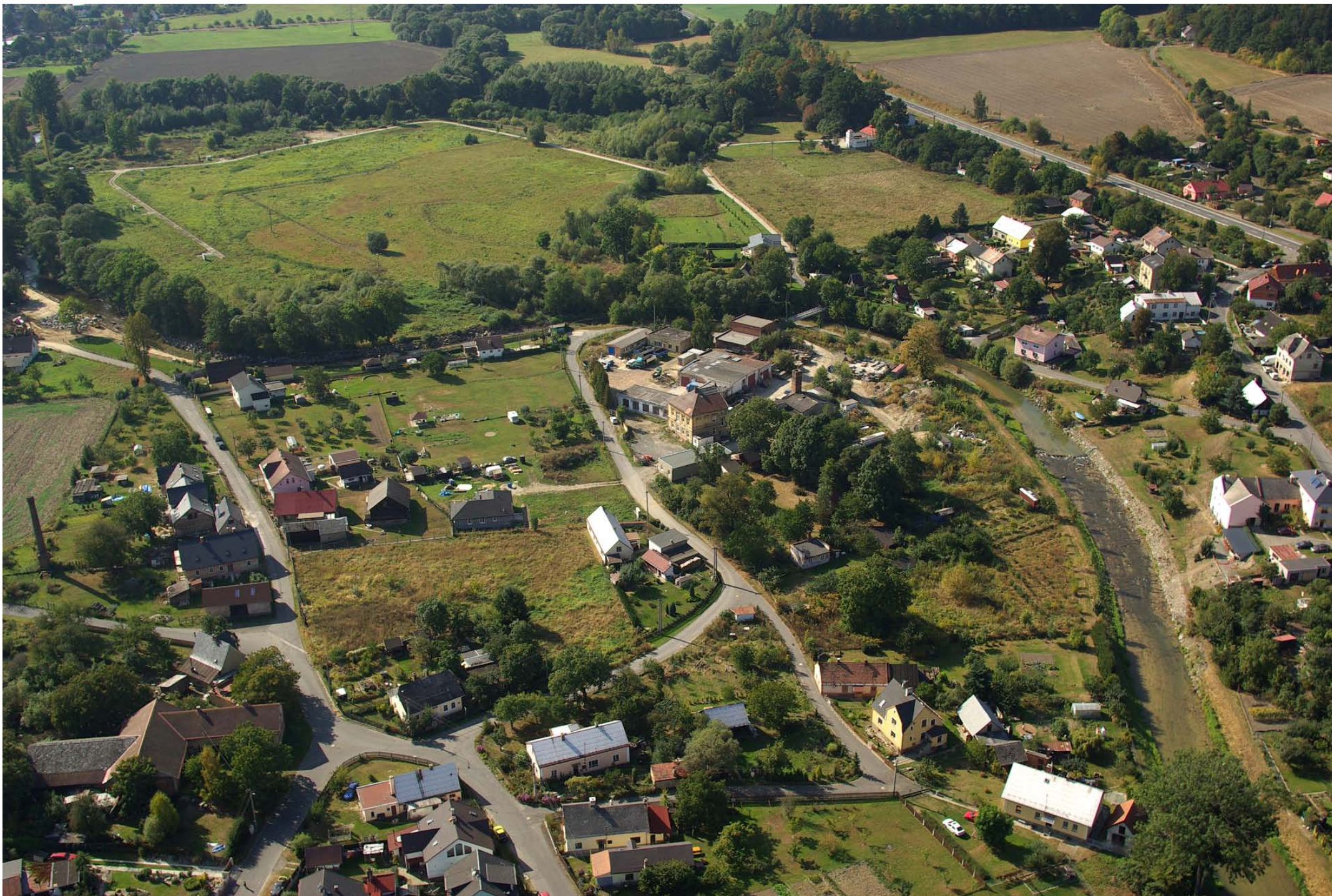
Město Krnov, část Kostelec, letecký pohled na oblast MVE a úsek pod jímacím zařízením KVAK – současný stav
