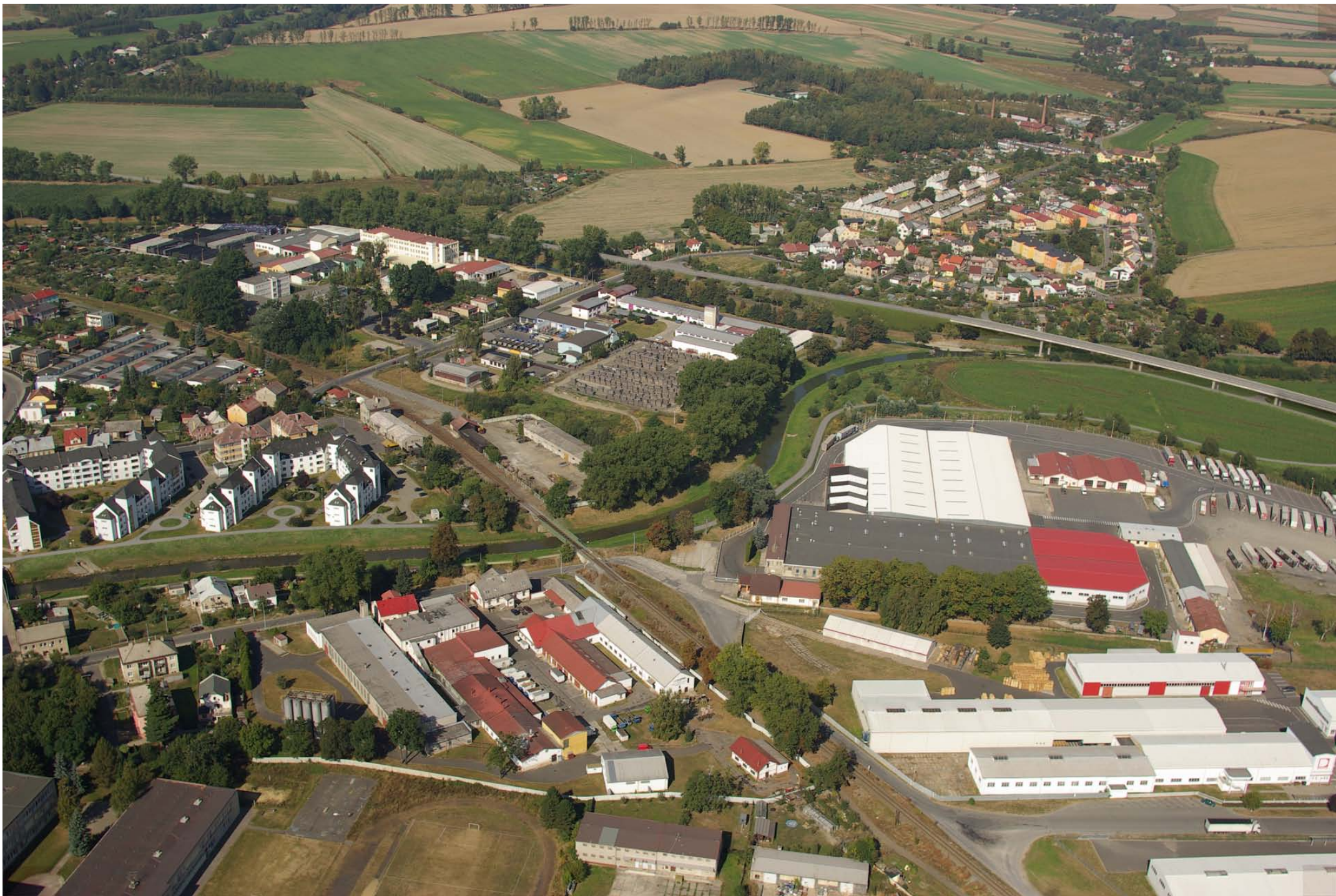
Město Krnov, letecký pohled na soutok Opavy s Opavicí - po realizaci úprav a obchvatu Krnova I/57
