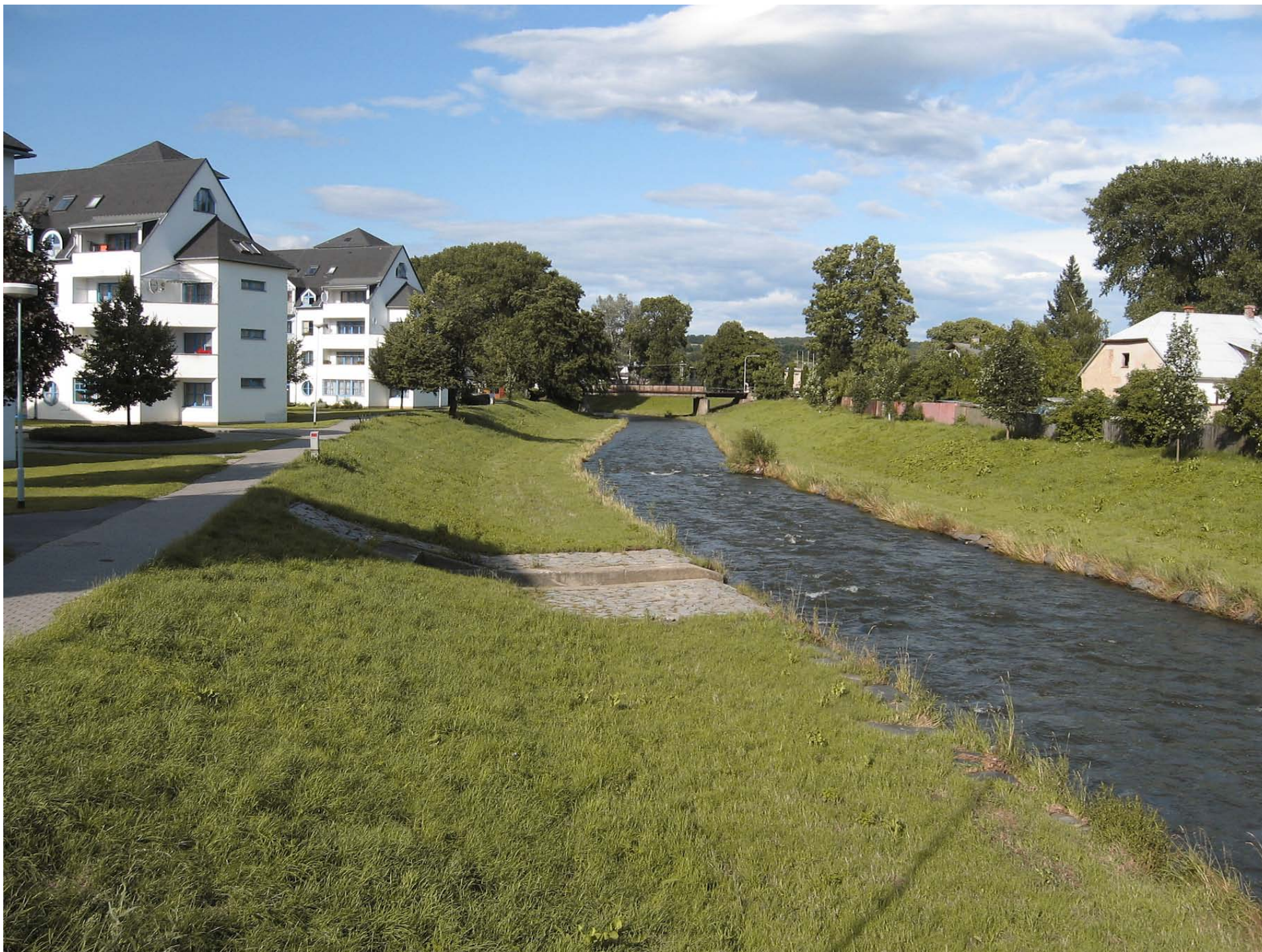
Město Krnov, pohled po vodě na nábreží u domu s pečovatelskou službou - současný stav
