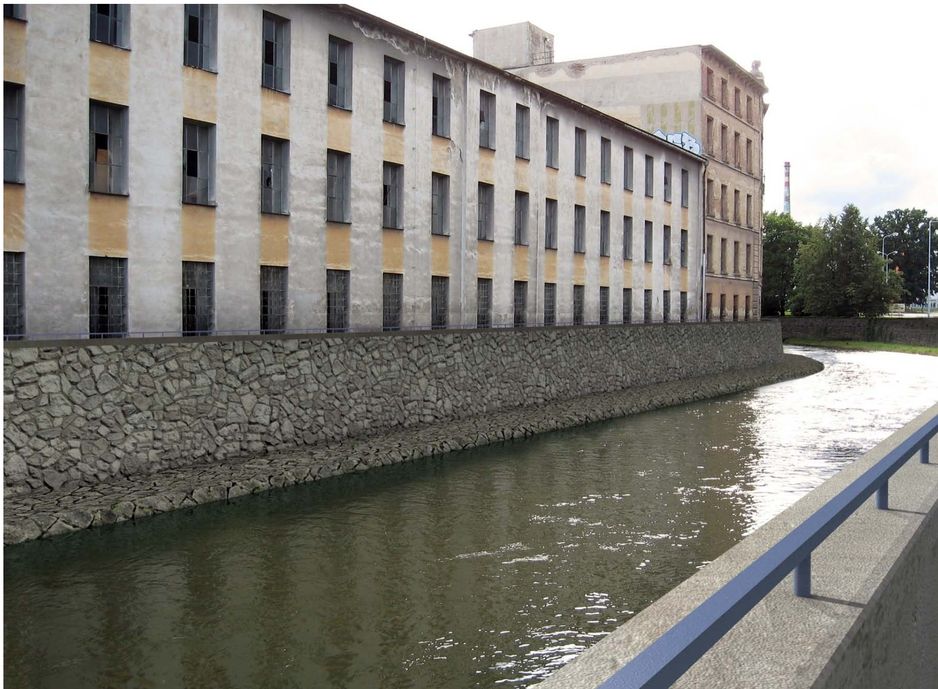
Město Krnov, pohled proti vodě na tovární halu Karnola - po realizaci navrhovaných opatření
