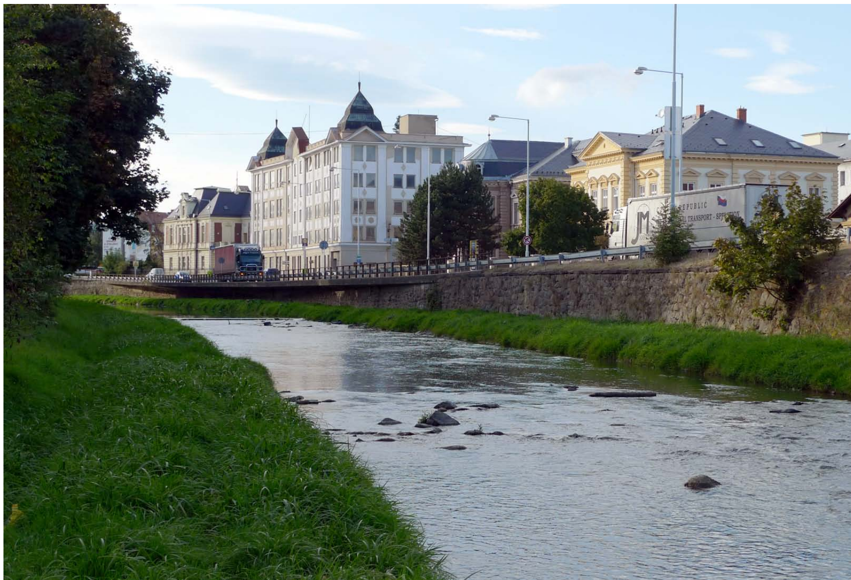
Město Krnov, pohled ze silničního mostu v km 70,350 dle TPE proti vodě na říční okruh - současný stav
