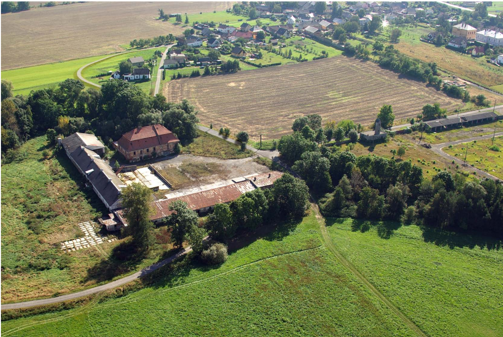
Obec Skrochovice, letecký pohled na pravobřežní zástavbu - po realizaci ochranné odsazené hráze
