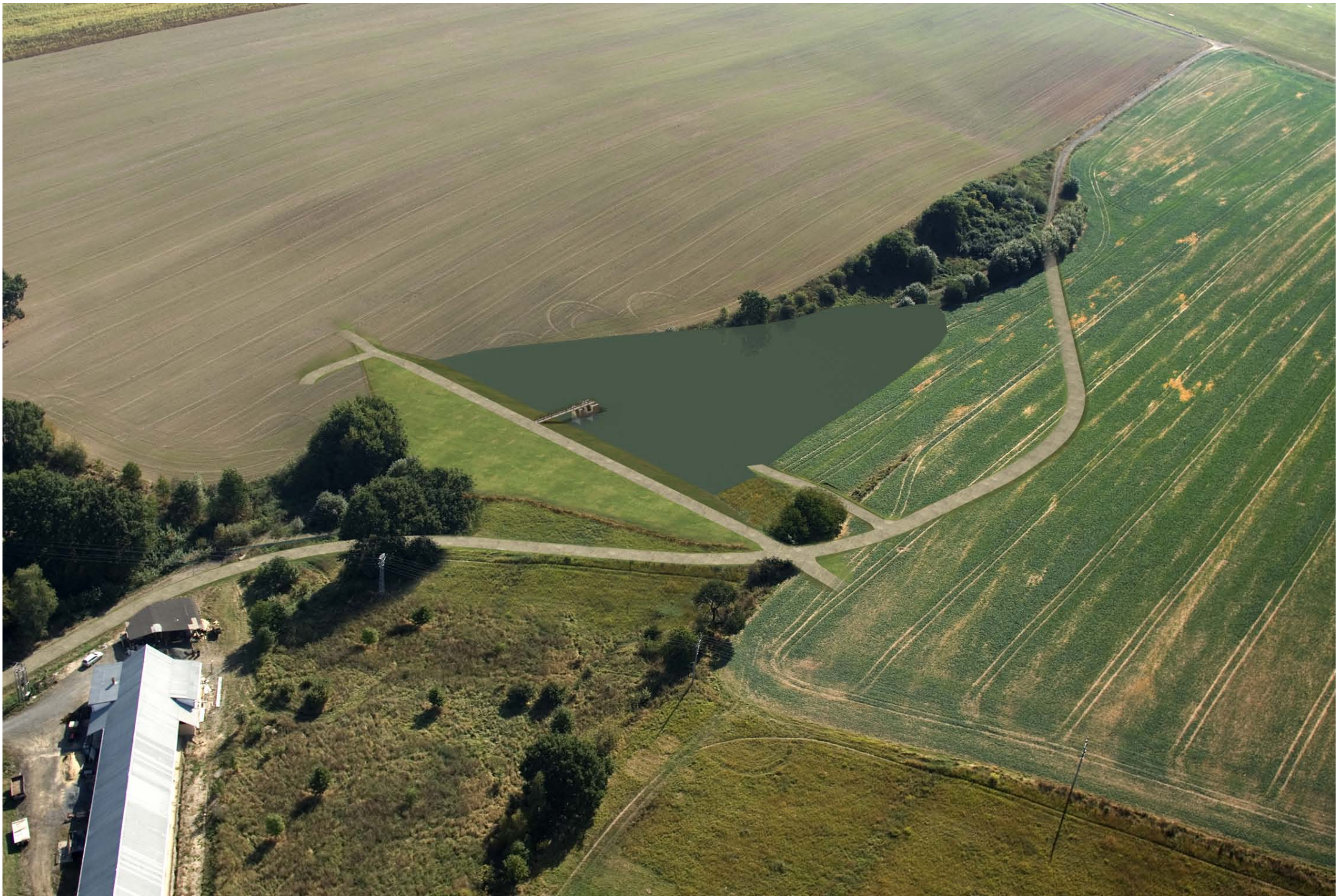
Nádrž Krnov, celkový letecký pohled - po realizaci nádrže
