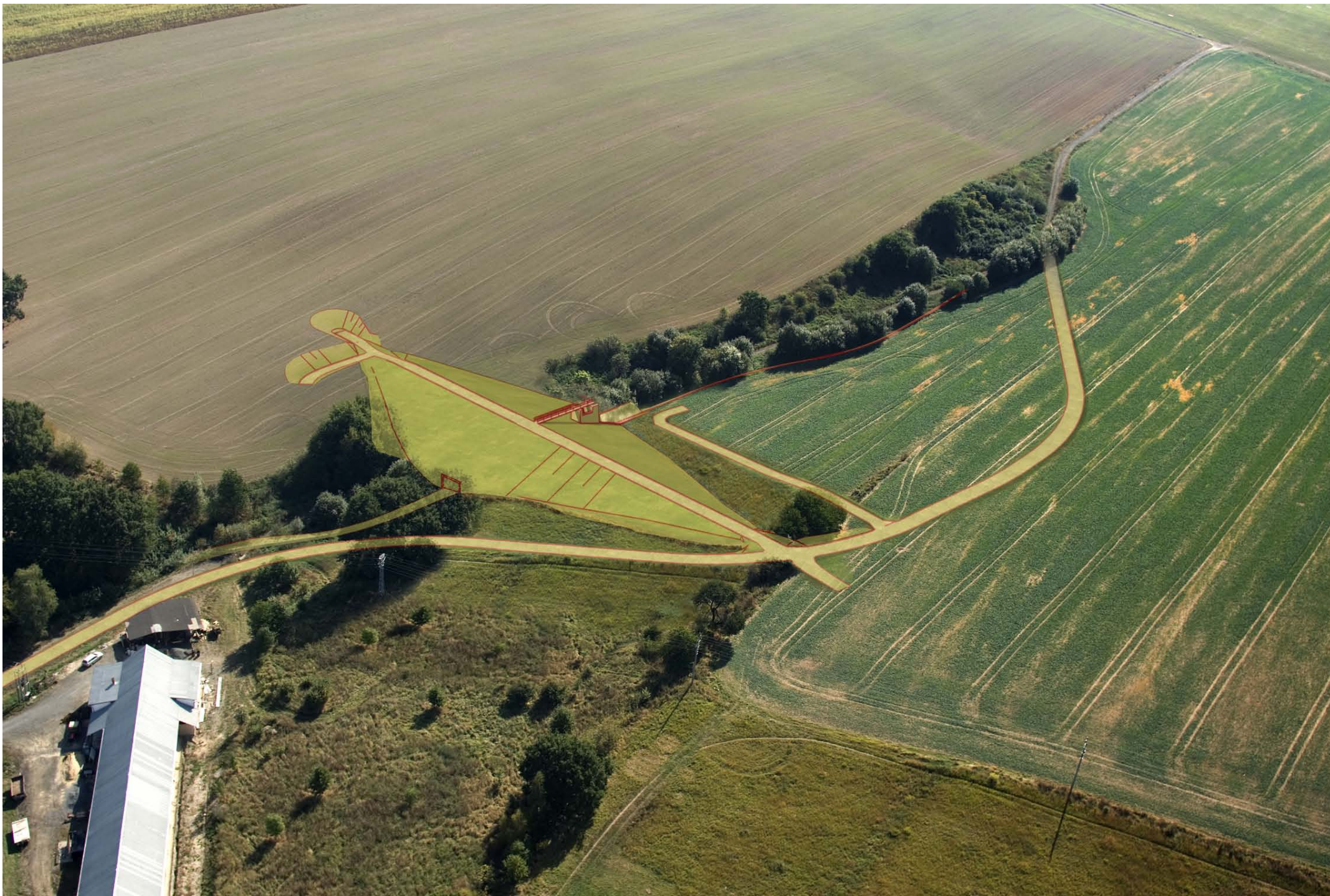
Nádrž Krnov, celkový letecký pohled (zvýrazněné kontury navrhovaných konstrukcí)
