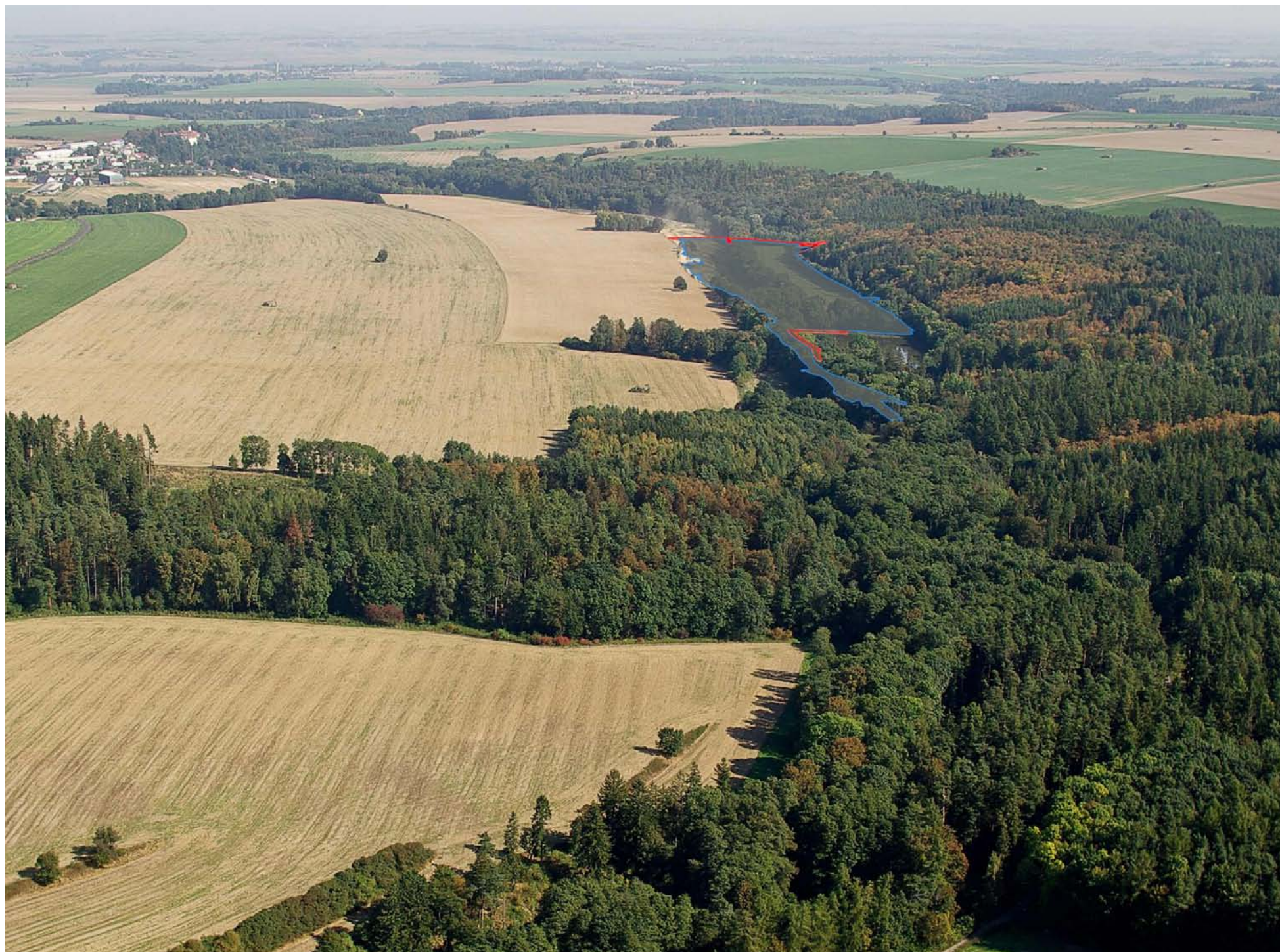
Nádrž Košetice, celkový letecký pohled - po realizaci nádrže
