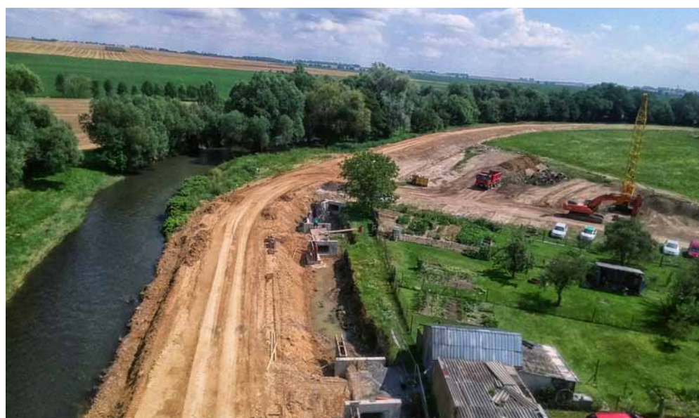
Násyp hráze a odvodňovací příkop na okraji zástavby obce Holasovice
