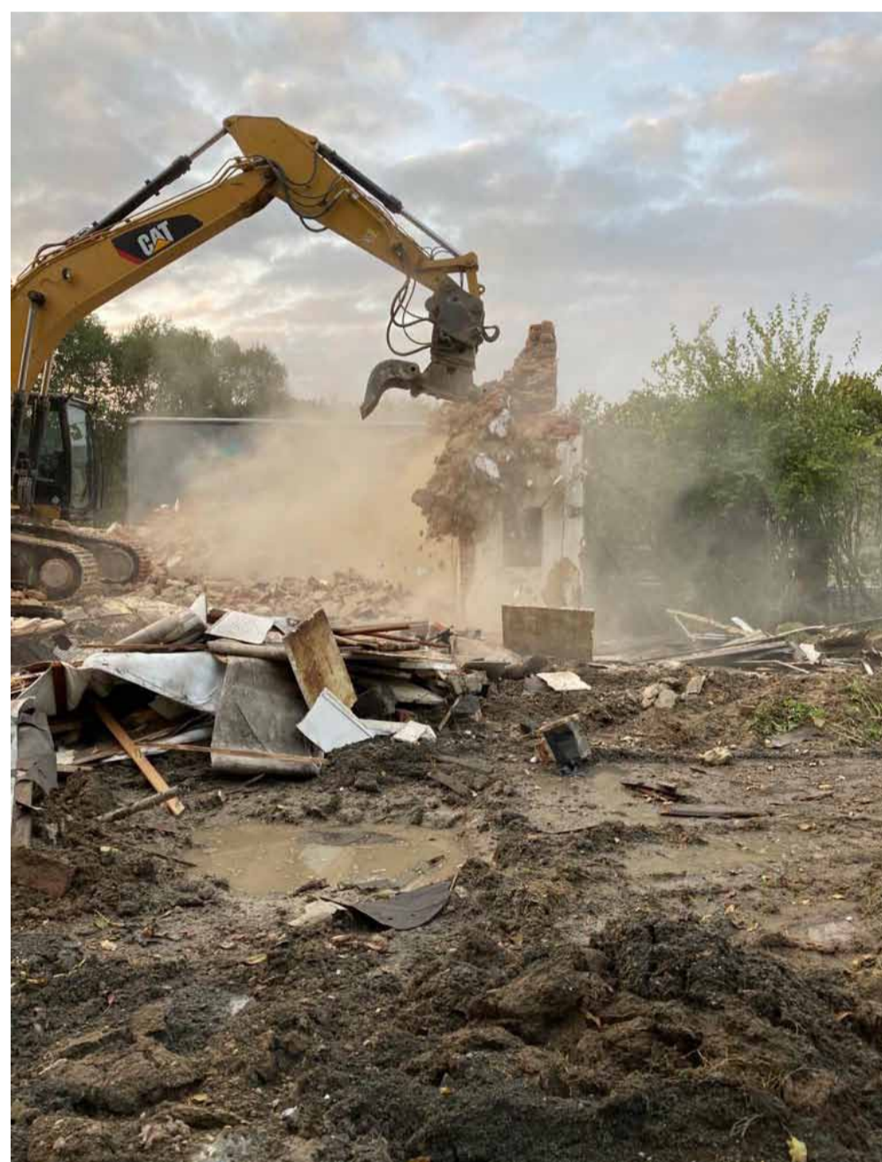
Demolice Nové Heřminovy
