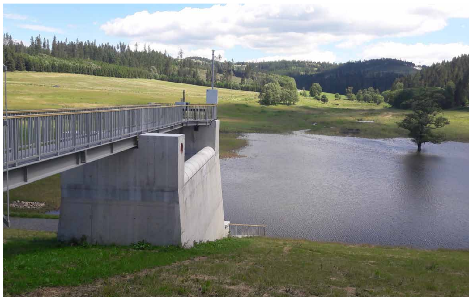
Pohled do zátopu nádrže ze dne 30. 6. 2020
