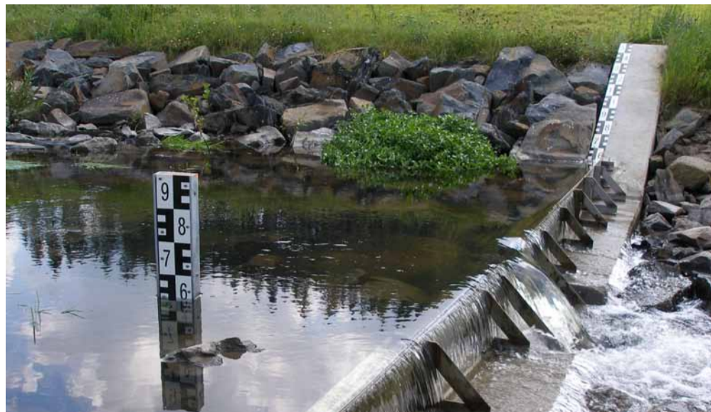
Měrná přepážka nové vodoměrné stanice na Kobylím potoce pod SN Jelení
