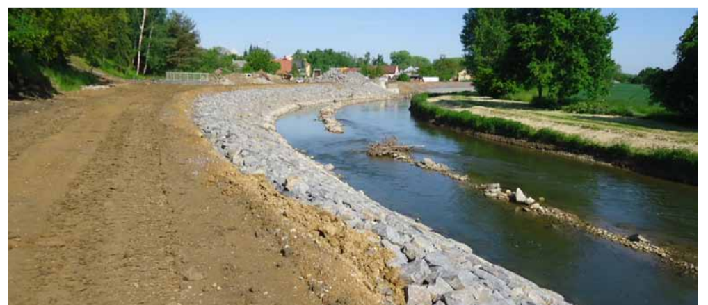
Opevnění svahu lomovým kamenem
