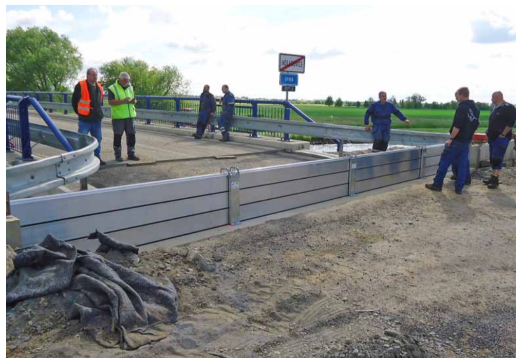
Zkušební osazení provizorního hrazení na mostě
