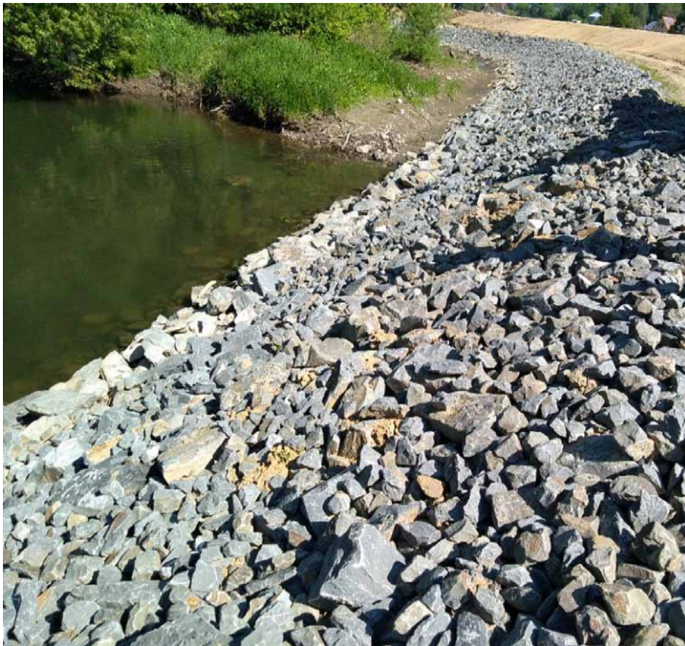
Opevnění břehu Opavy v km 66,5
