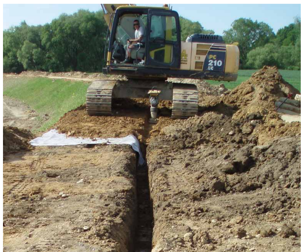
Pokládka bentonitové rohože ke cloně
