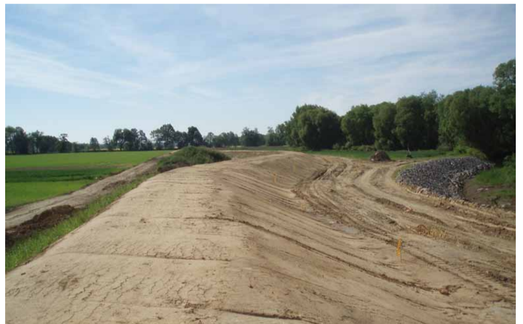
Svahování hráze, vytyčení okolních komunikací
