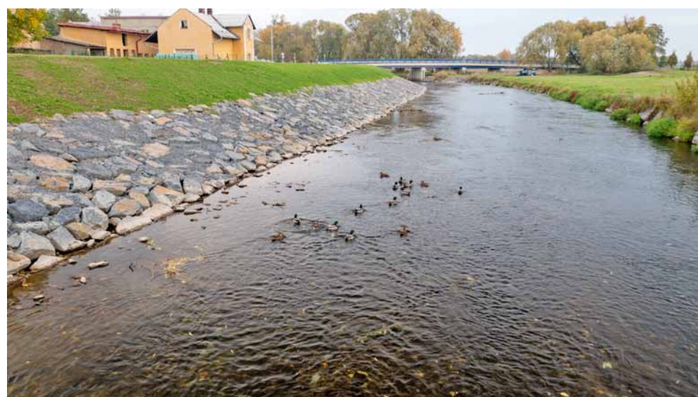
Pohled na kamenné opevnění s nasazenou pravobřežní říční hrází
