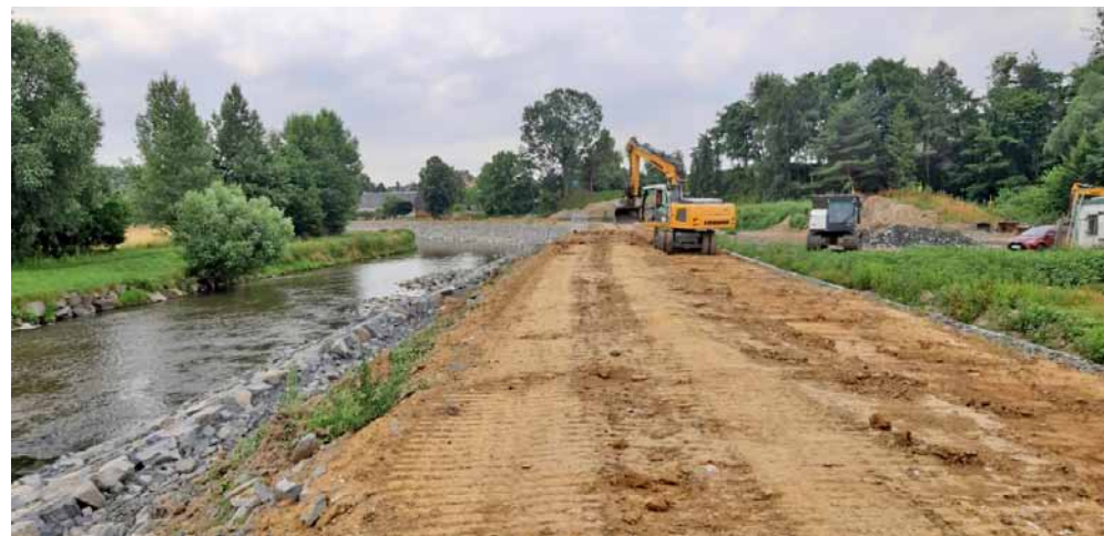
Holasovická hráz ve výstavbě
