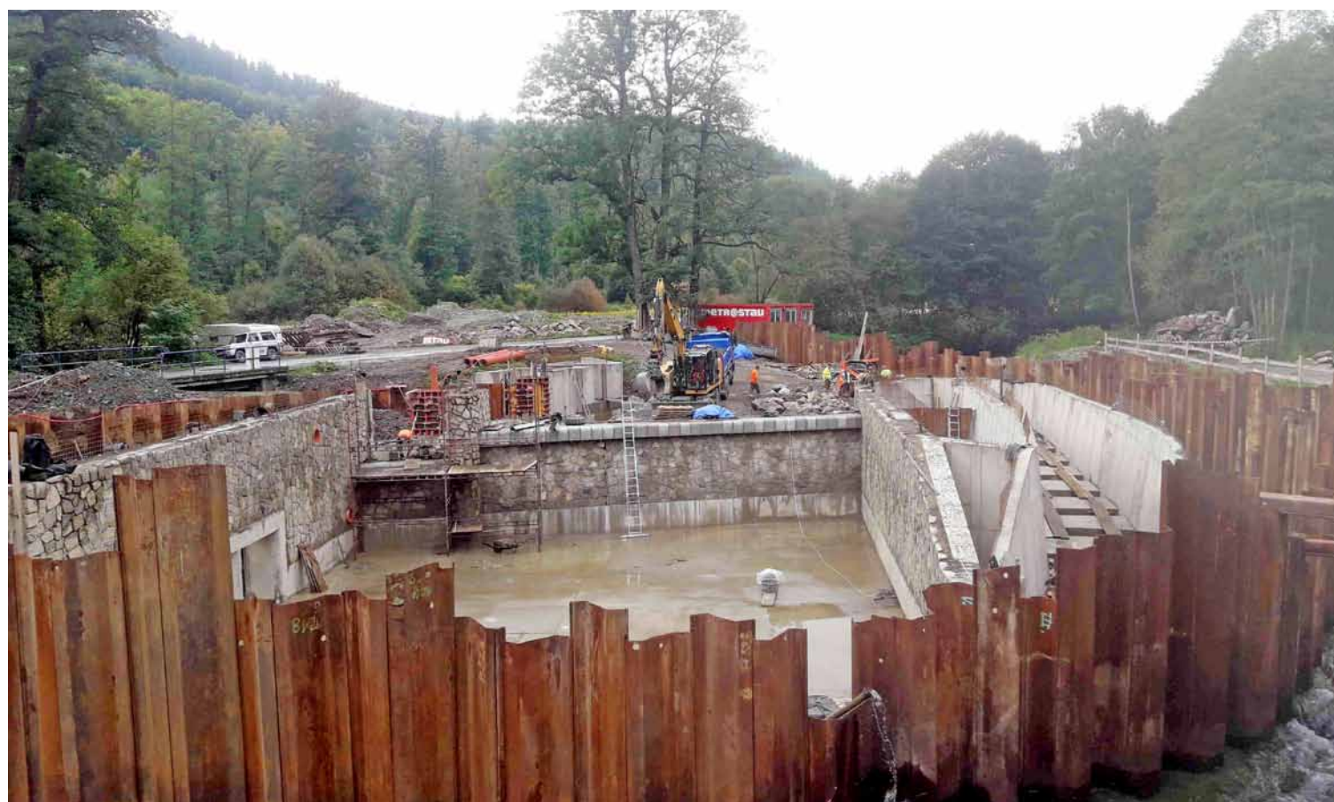
Jez Kunov ve výstavbě
