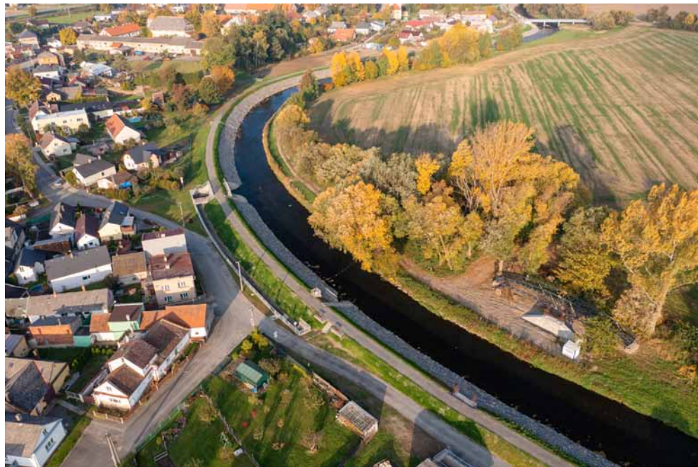
Letecký pohled na zhotovené protipovodňové opatření pro obec Holasovice
