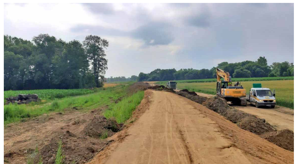
Budování poslké hráže
