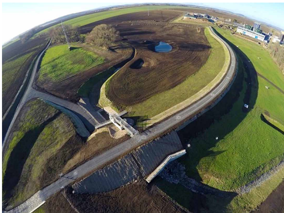
Pohled na kamenné opevnění s nasazenou pravobřežní říční hrází
