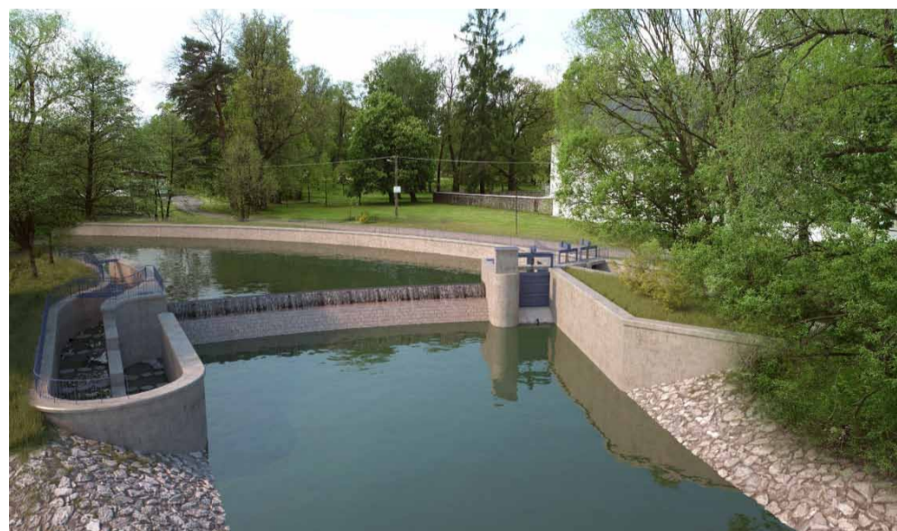
Pohled proti proudu (z mostu) řeky Opavy na nový jez a okolí
